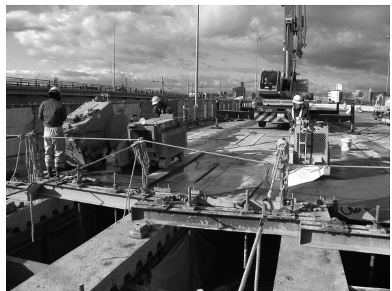
図-2 ロードカッターによる大割り作業
