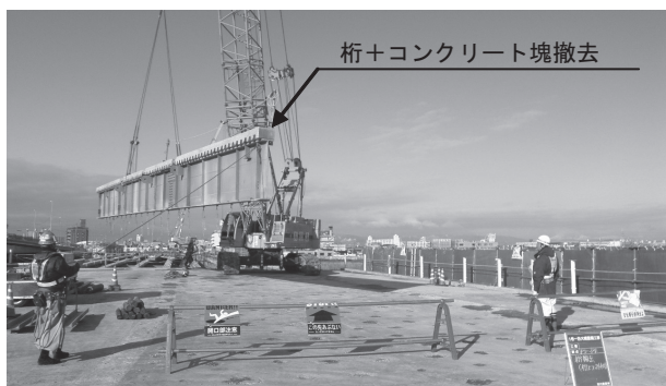
図-3-1 大型クローラクレーンによる撤去
