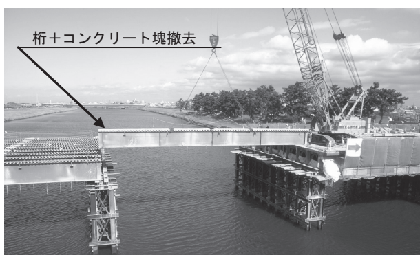
図-3-2 大型クローラクレーンによる撤去
