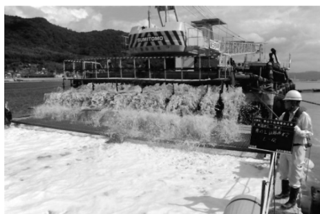
図-3 散布台船による施工状況
