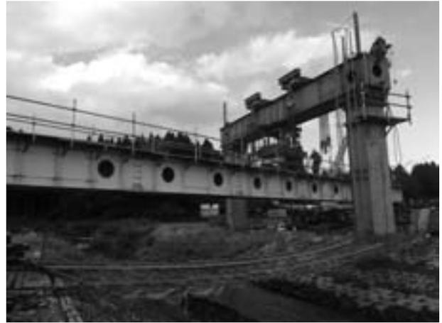
図-4 主桁横移動門構の縦移動
