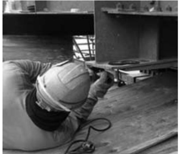
図-8 ソールプレート撤去状況
