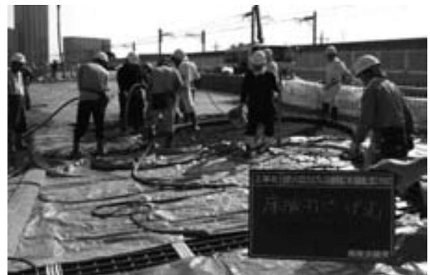
図-3 コンクリート打設状況
