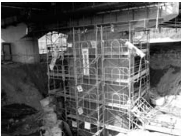
図-4 巻き立てコンクリートの養生
