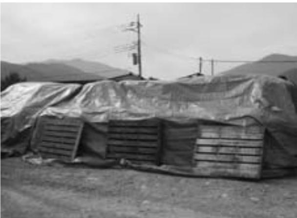
図-10 DM 製品養生状況
