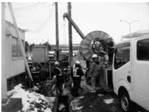
図-3 【SPR工法】製管状況
