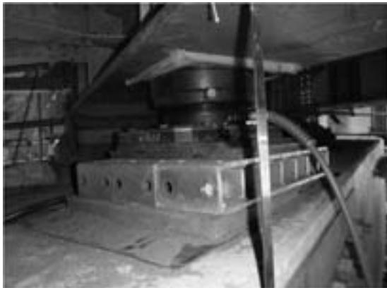
図-5 油圧ロックジャッキ設置
