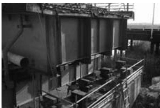
図-10 桁扛上後 (P3 橋脚)
