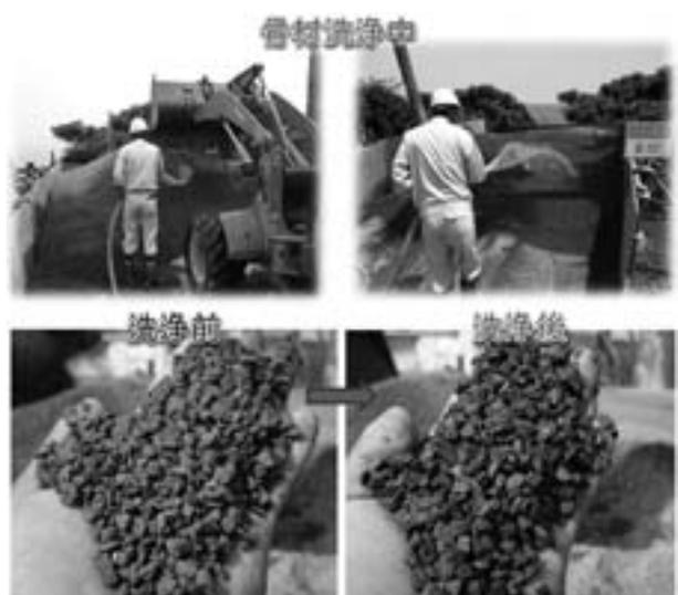
図-7 骨材洗浄状況
