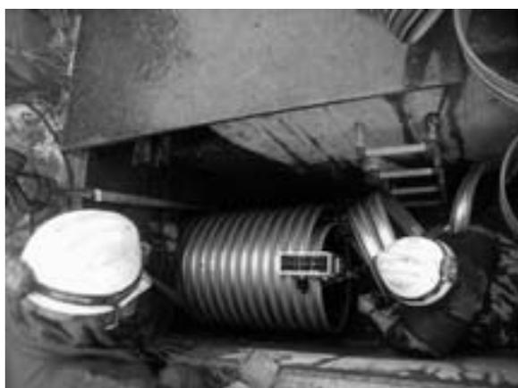
図-4 【SPR工法】製管状況
