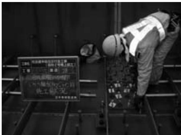
図-8 スタッドジベル施工状況
