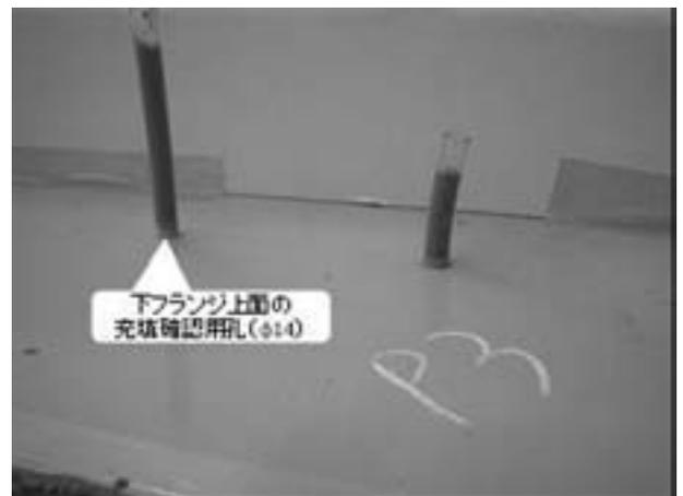
図-7 空気孔による充填状況の確認
