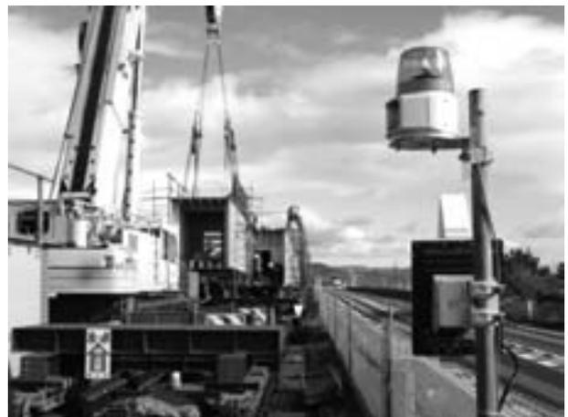
図-4 クレーン作業警報監視システム
