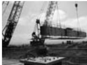
図-6 補剛桁相吊架設
