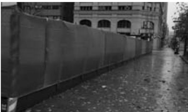
図-4 仮囲い設置（防塵ネット設置）
