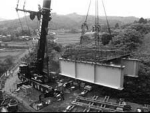
図-1 剛結部のブロック化による架設
