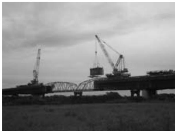
図-1 トラベラークレーン架設
