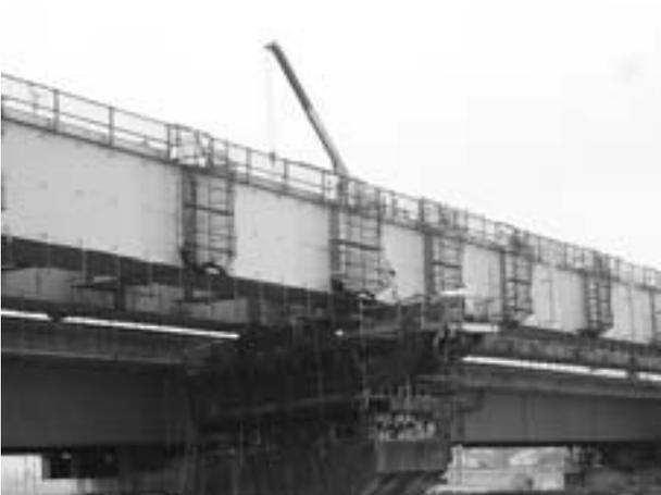
図-9 小型クレーン装置（P1支点上）
