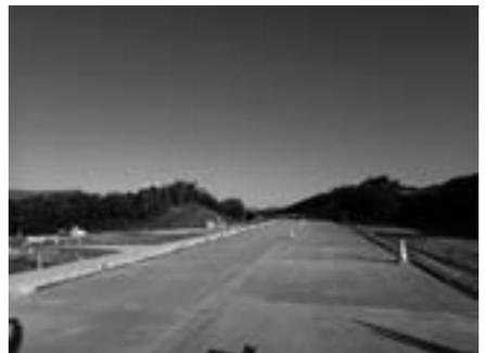
図-5 コンクリート舗装の完成路面
