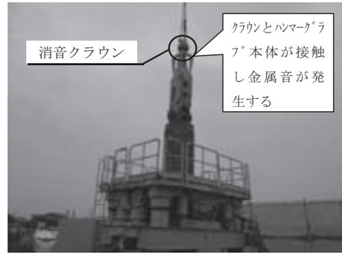
図-5 ハンマーグラブによる掘削状況
