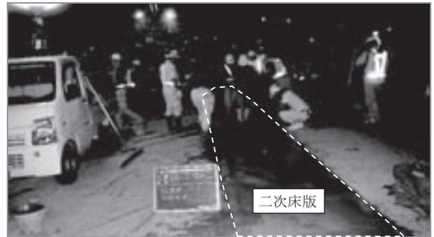
図-12 二次床版コンクリート打設
