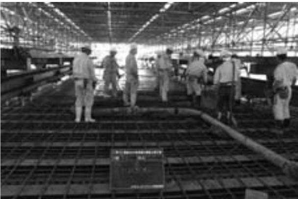
図-10 床版コンクリート打設状況
