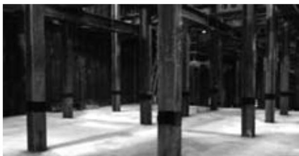
図-5 中間杭スパンシール設置完了
