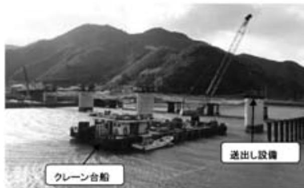
図-4 クレーン台船使用状況
