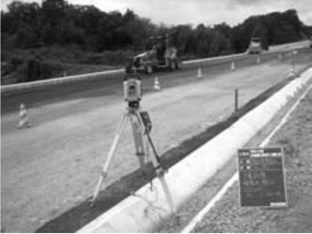
図-2 TSの設置状況（下層路盤工）
