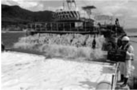
図-3 散布台船による施工状況
