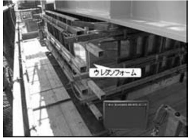
図-3 養生材を貼り付けた型枠組立
