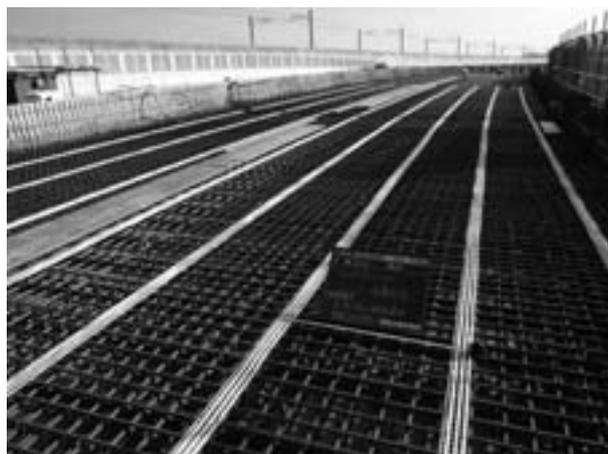
図-5 ひび割れ低減材の敷設状況
