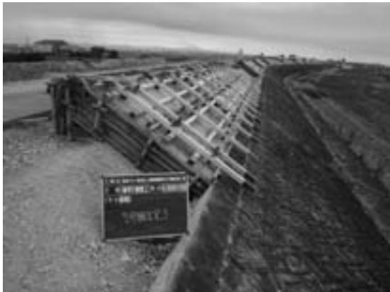
図-4 パラペット先行施工状況 L=380m
