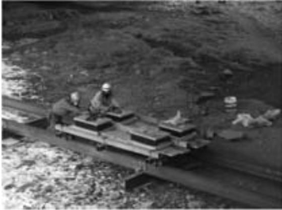
図-8 軌条設備を使った運搬
