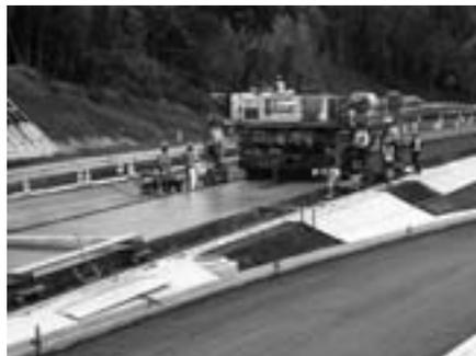
図-4 スリップフォームペーパーによる施工状況
