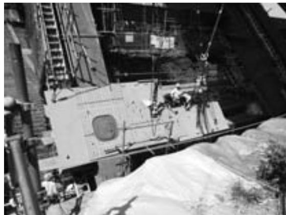
図-9 部材据付状況(方杖基部)
