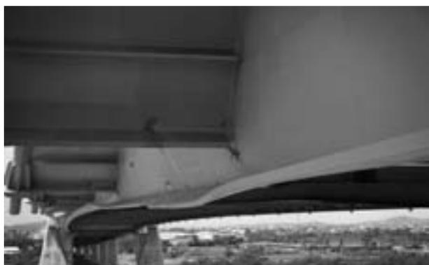
図-4 主桁損傷状況
