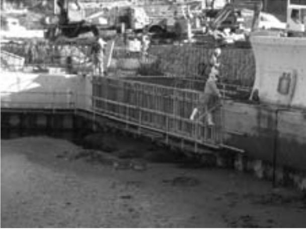
図-2 前面型枠組立状況
