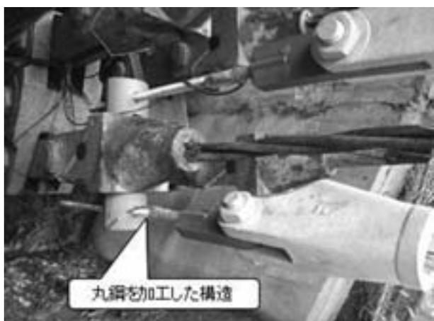
図-5 ロッド定着構造
