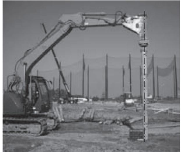
図-4 木杭とブレーカの鉛直性が確保された状態
