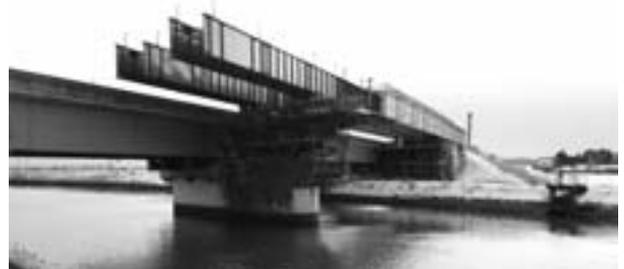
図-2 鋼桁の送出し状況
