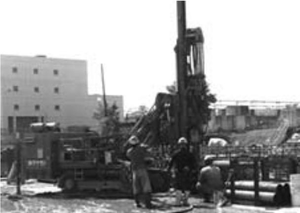
図-7 ロータリーパーカッション掘削機
