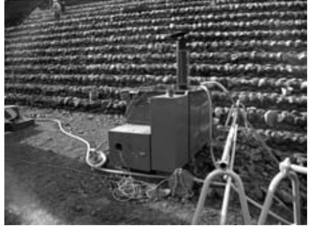
図-11 練混ぜ水加温設備
