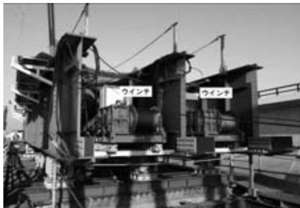
図-4 架設桁先端牽引設備
