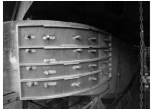
図-10 曲線ブラケットの設置確認
