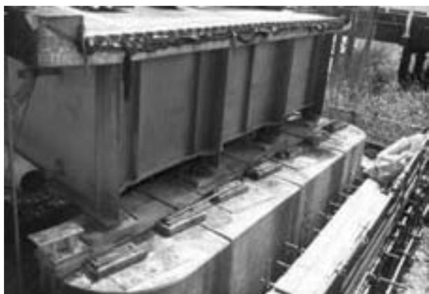
図-9 桁扛上前 (P3 橋脚)
