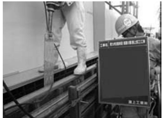
図-6 小型の専用バイブレータ
