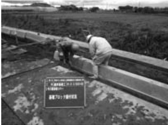
図-3 基礎ブロック据付状況 L=960m
