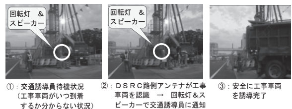
図-5 交通誘導員への回転灯・スピーカーによる車両接近通知状況
