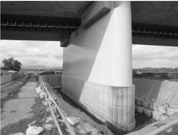
図-9 P-5橋脚耐震補強完了
