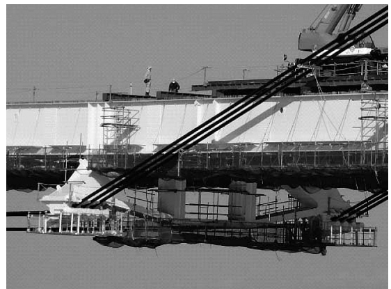
図-16 本ケーブル架設完了
