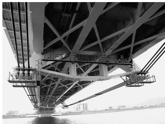
図-6 下サドルケーブル設置状況
