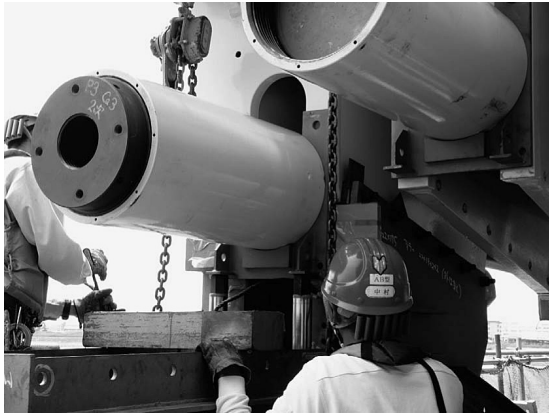
図-13 水平ケーブルスライドアップ状況
