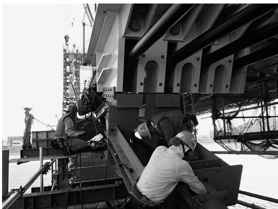
図-15 斜ケーブル引込み状況
