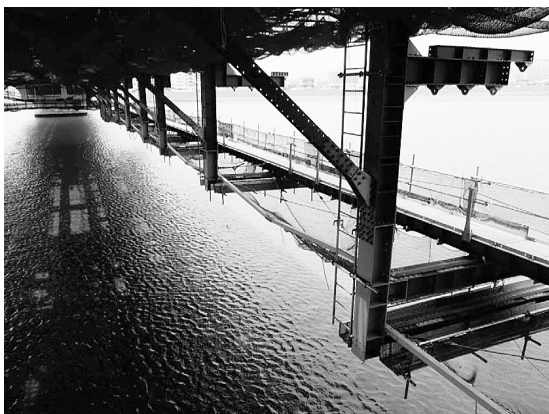
図-10 ケーブル展開設備
