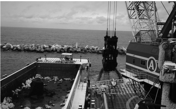
図-5 グラブ浚渫船によるケーソン撤去状況
