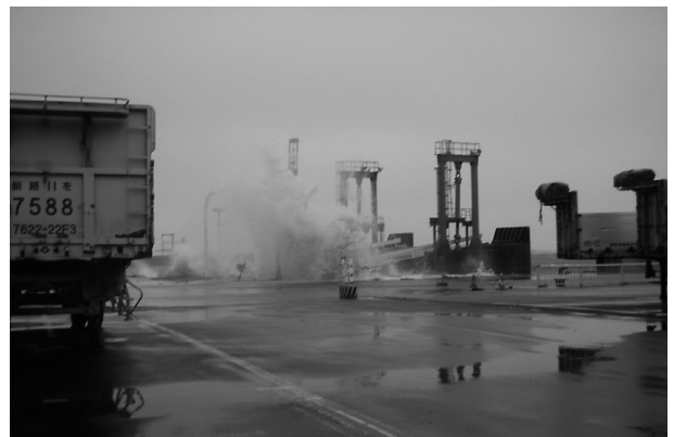
図-3 高波浪時の港湾施設（フェリーターミナル）
