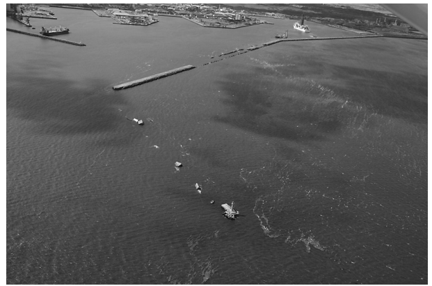
図-2 防波堤被災状況（提供：八戸港湾・空港整備事務所）
