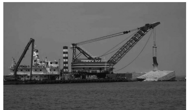
図-12 砕岩棒刃先制御治具を用いたケースン破砕状況
