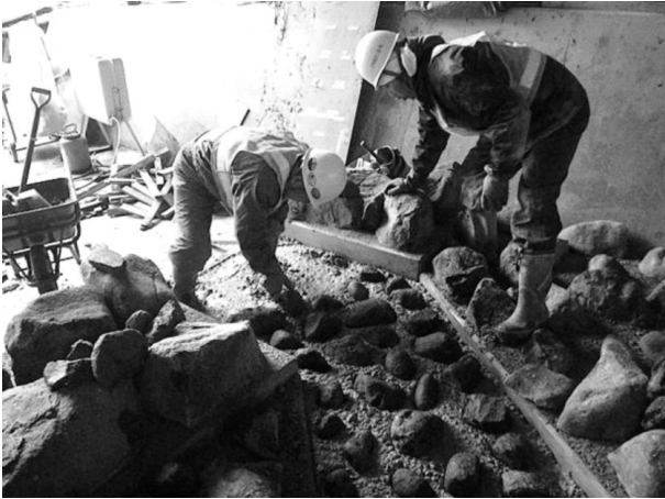
図-10 流路部施工状況
