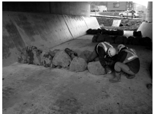
図-9 帯工据付状況
