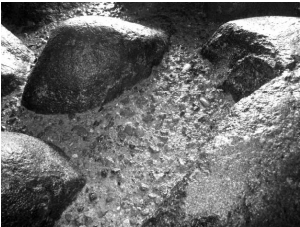
図-11 流路部洗出し状況
