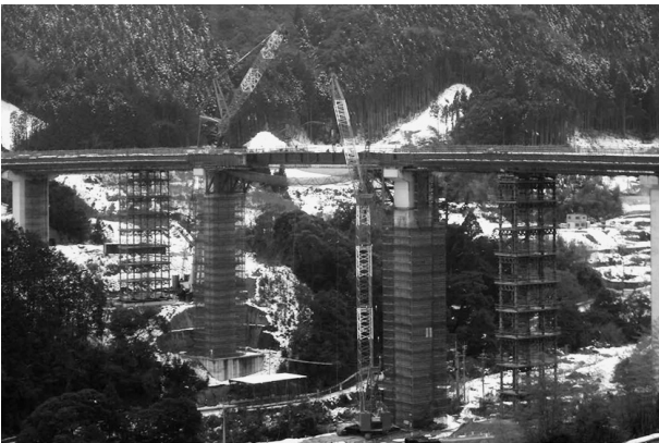
図-1 落とし込み架設状況
