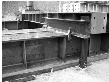
図-4 ベント基部の安定化
