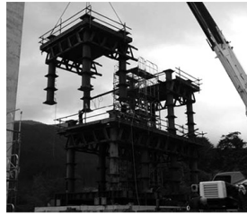
図-6 ベント組立状況
