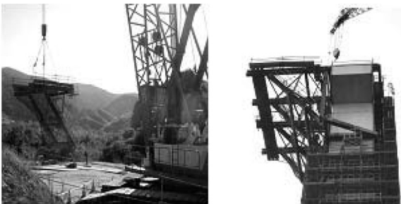
図-8 斜ベント架設・設置状況
