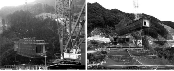
図-11 主桁架設状況
