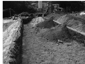
図-9 地盤改良状況
