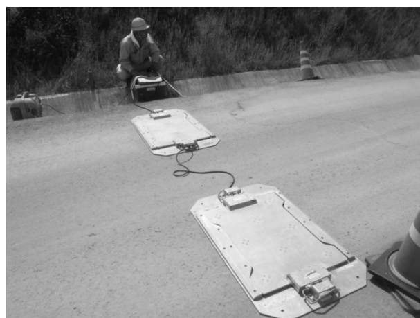
図-3 トラックスケールによる積載重量測定状況
