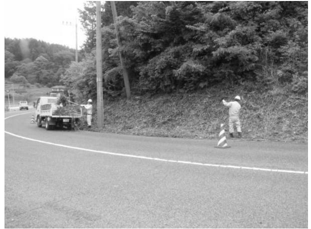
図-7 運搬経路内の一般道草刈状況
