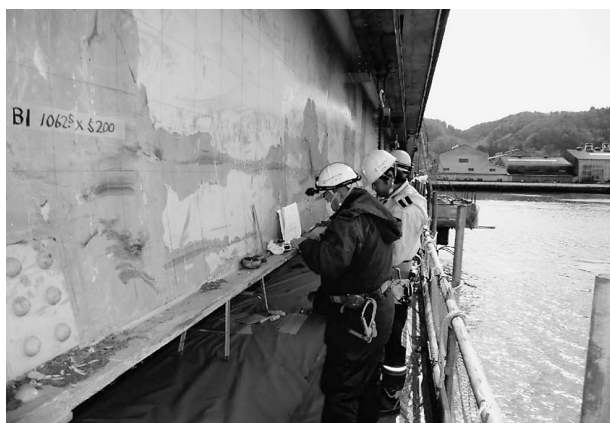
図-2 主桁損傷の調査状況
