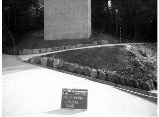
図-10 土砂流出防止石積群
