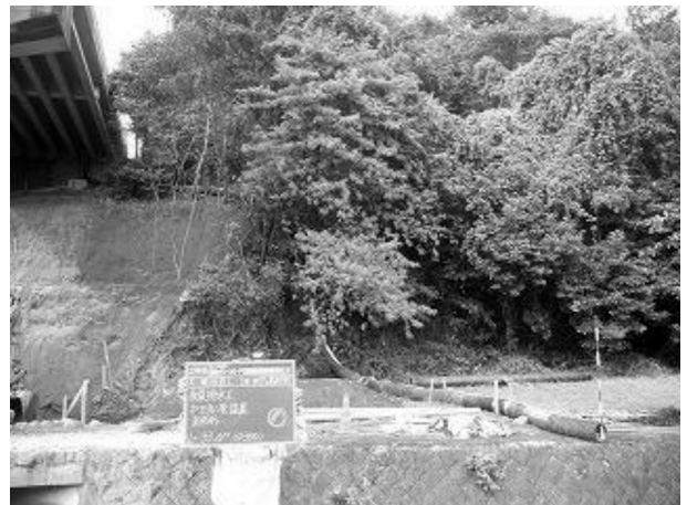
図-7 仮設排水誘導管
