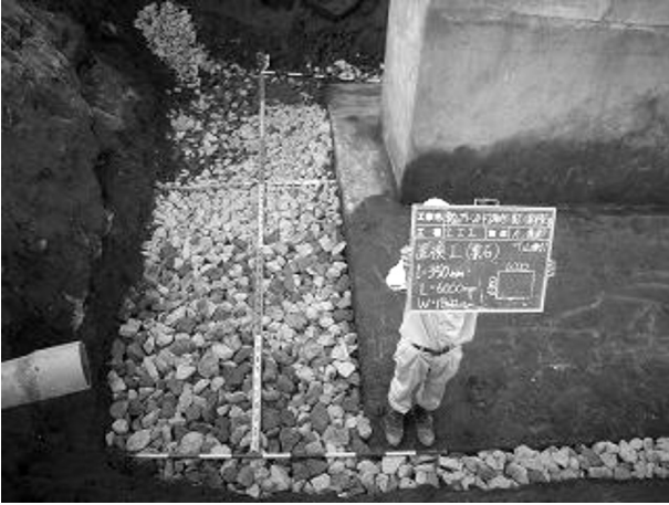
図-8 軟弱地盤層栗石置換工
