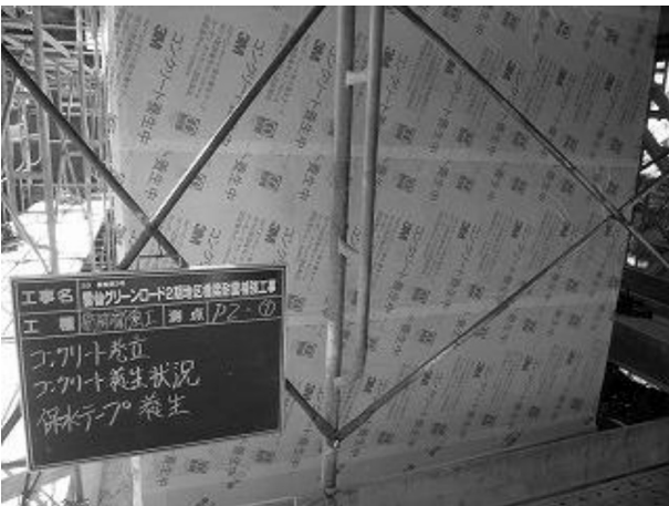
図-5 コンクリート保水養生テープ
