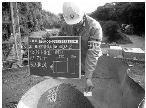
図-3 コンクリート分離低減剤投入 （※コンクリート分離低減剤入りの生コンクリートは試験練りによる、基準の確認後に使用しました。）
