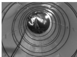
図-13 養生状況 (LHTシート)
