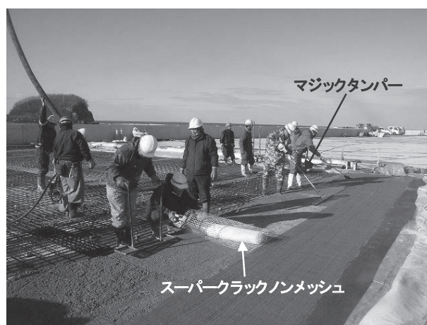
図-5 コンクリート打設状況
