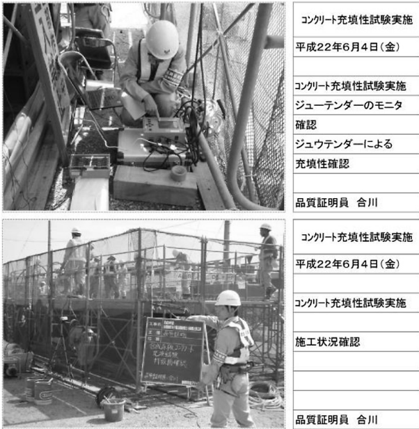
図-4 実物大供試体にて充填性確認
