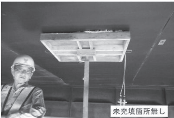
図-8 赤外線サーモビューアーによる充填性確認
