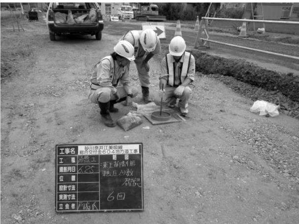
図-7 試験転圧密度試験
