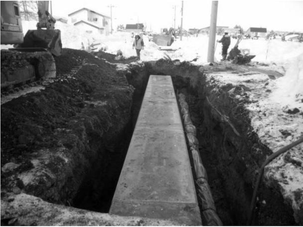
図-4 縦断管と水道管
