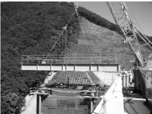
図-6 塔上ガーダ一体架設・据付状況
