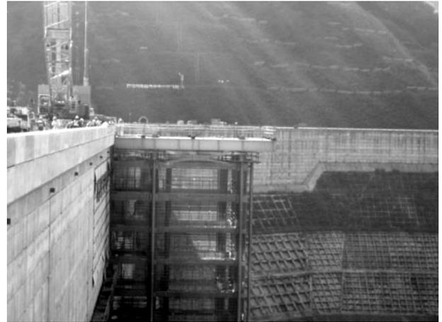
図-7 塔上ガーダ据付完了
