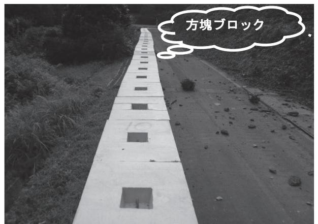
図-8 方塊ブロックの設置
