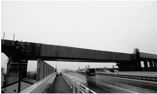
図-10 吊足場組立完了
