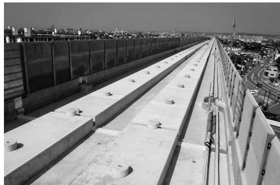
図-14 路盤コンクリート完了
