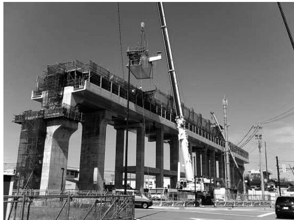
図-4 桁組立状況
