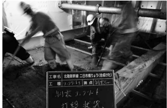
図-13 制振コンクリート打設状況
