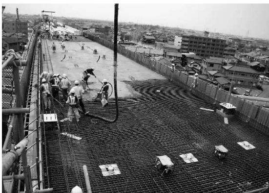
図-12 床版コンクリート打設状況
