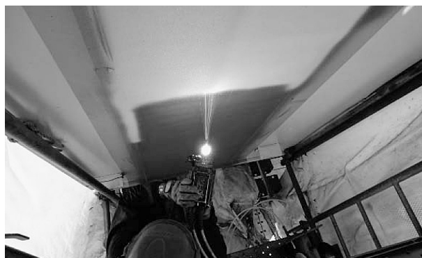
図-5 亜鉛・アルミ常温溶射
