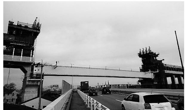
図-9 桁降下完了
