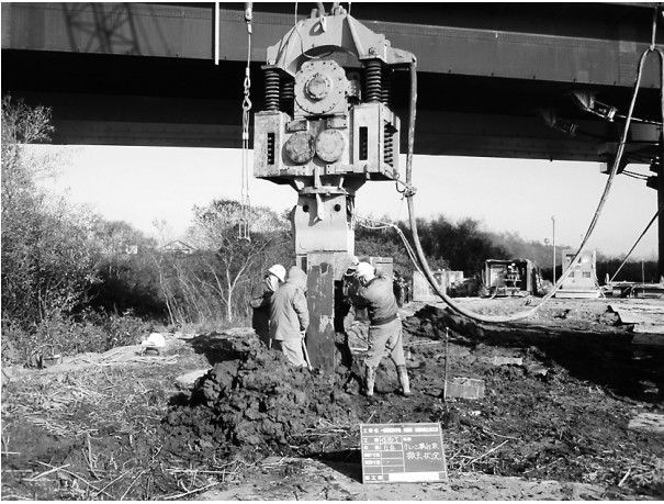
図-8 ウォータージェット併用の杭抜き作業
