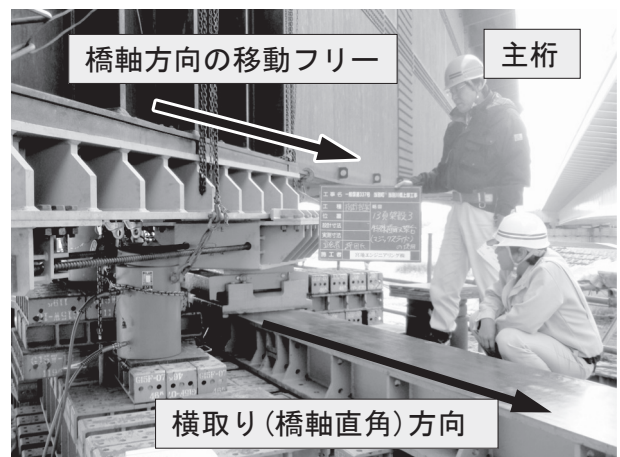
図-6 二軸スライド装置の使用状況②
