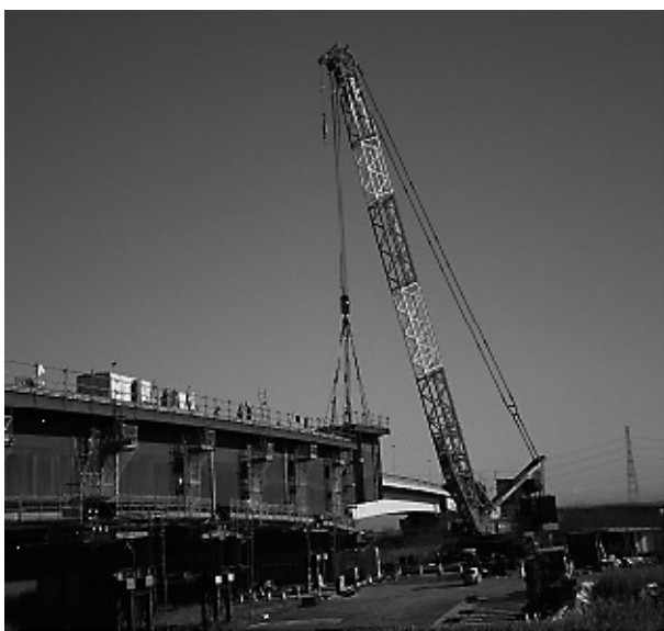
図-4 横取り架設前の桁架設状況
