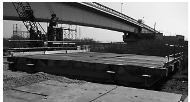
図-3 クレーン構台設置状況
