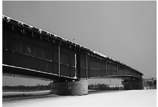
図-9 桁架設完了外観
