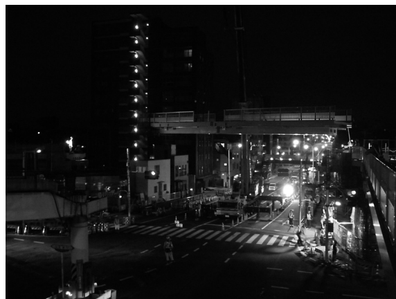
図-11 一時通行止めが伴う架設状況
