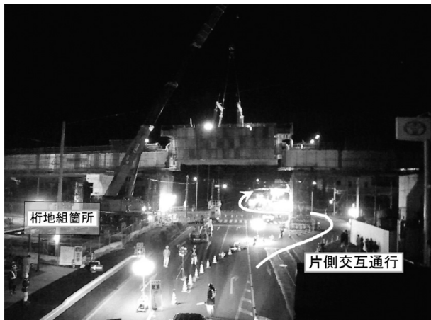
図-4 国道上架設
