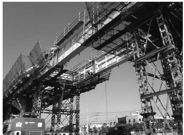
図-5 調整桁架設
