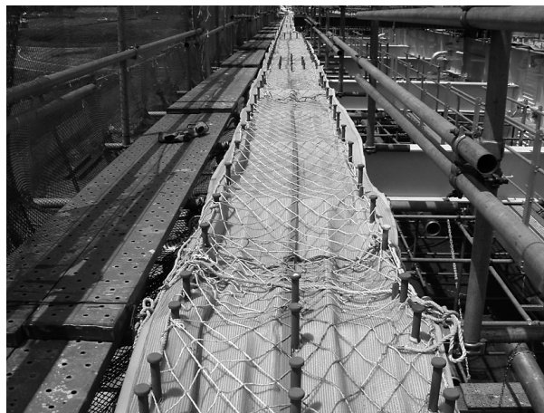
図-7 桁の冷却状況
