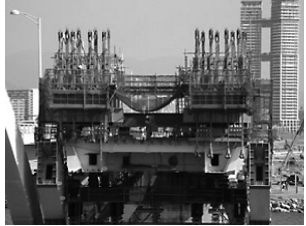
図-7 吊上げ設備 (全景)
