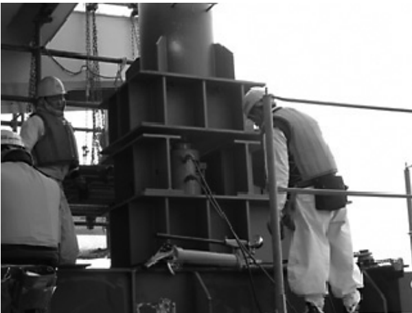
図-6 台船上での反力調整
