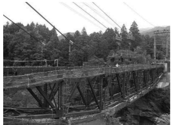
図-8 桁架設状況
