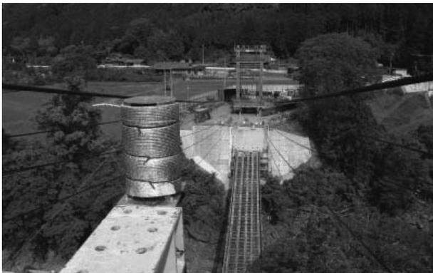
図-10 鉄塔傾斜設置
