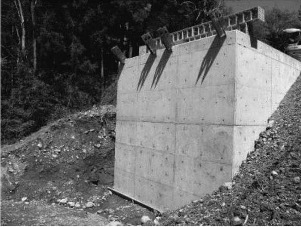
図-5 補強土壁、重力式擁壁を兼ねた
