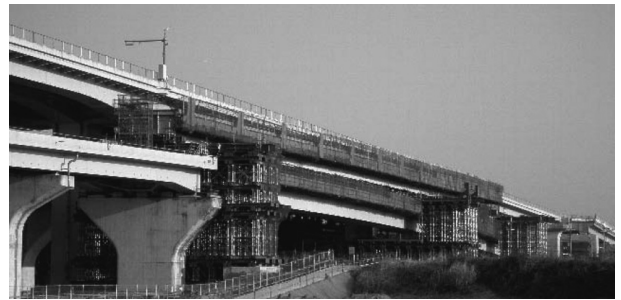
図-5 三宅IC橋／OFFランプ縦取り架設状況
