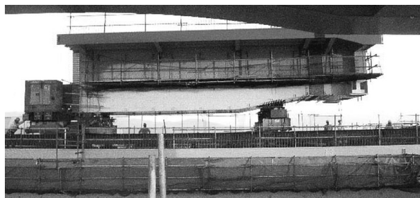
図-9 縦取り軌条設備・ランプ部鋼桁運搬状況
