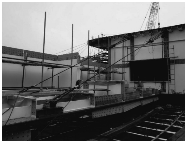
図-9 分割ブロックたわみ防止装置
