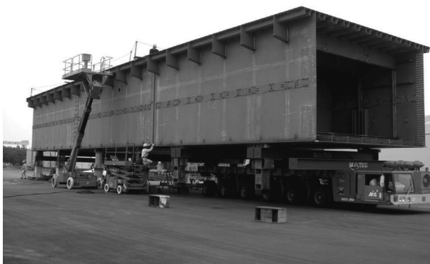
図-8 箱断面ブロック運搬・仮組状況
