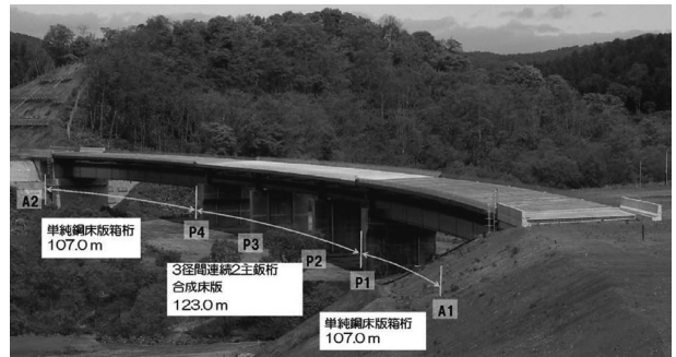
図-2 工事箇所全景
