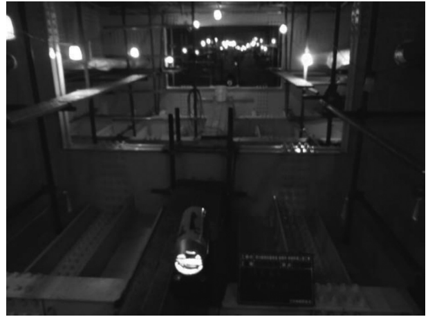
図-12 現場塗装工寒中養生状況
