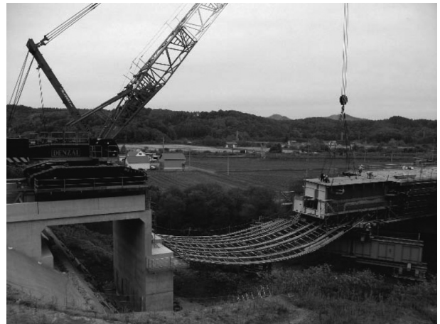
図-6 既設構造物防護構台 (A2 橋台350t クレーン)
