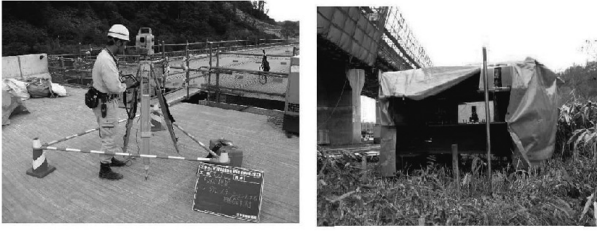
図-10 ベント及び桁高計測状況
