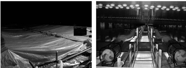
図-11 コンクリート寒中工養生状況
