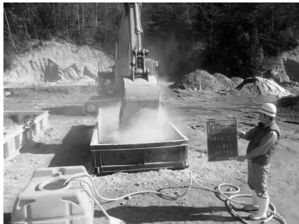
図-4 バックホウ混合時のセメント粉塵の例
