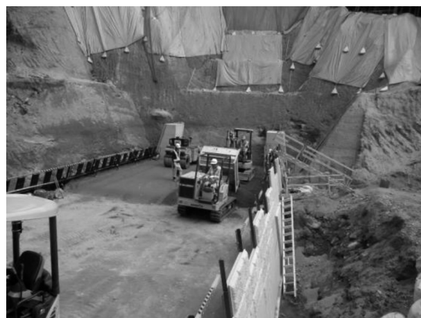
図-8 不整地運搬車による運搬
