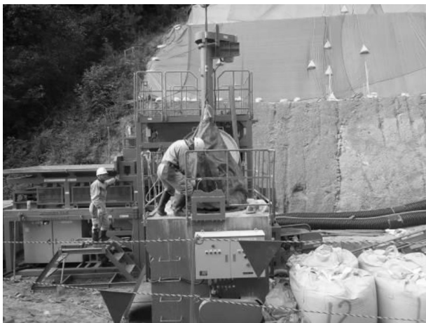
図-6 セメント投入時の防塵シート
