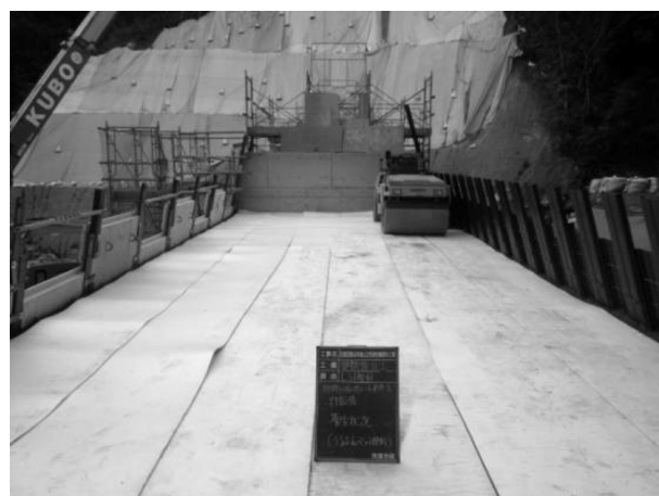
図-9 保温養生マット敷設状況
