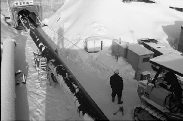
図-7 トンネル坑内への延管状況
