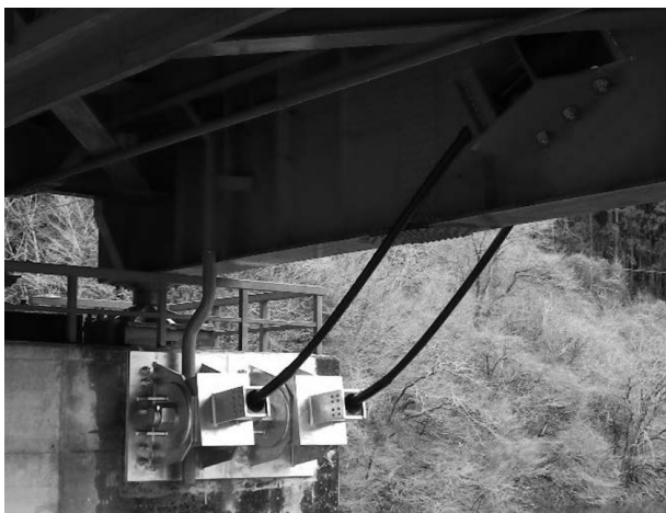
図-3 落橋防止装置設置状況
