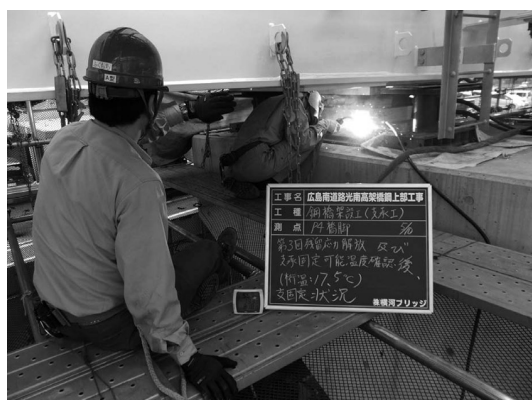
図-4 P4支承固定状況
