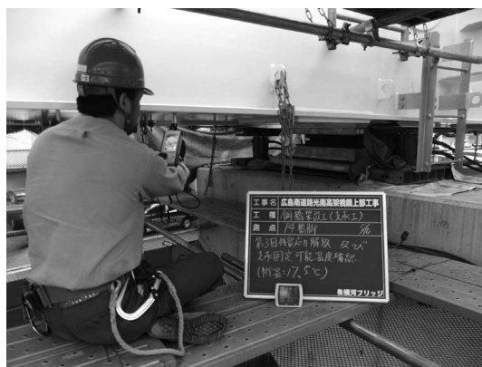
図-3 P4支承固定時桁温計測状況
