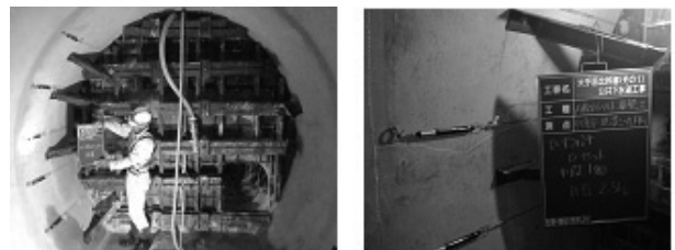
図-1 歪みセンサー設置
