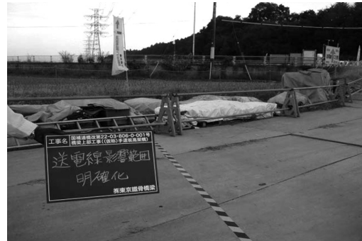
図-5 送電線の安全離隔距離の明確化
