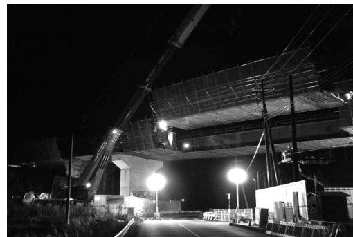
図-6 県道上のブロック架設状況
