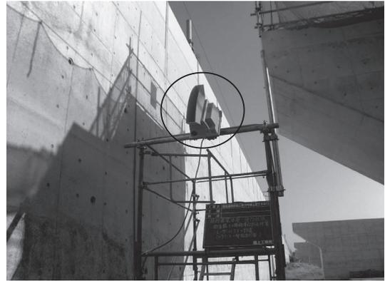
図-4 レーザーバリア設置状況
