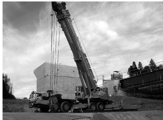
図-5 吊りフックの接地・クレーンブームの退避
