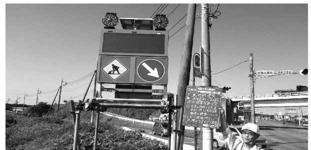
図-2 LED サインライトの設置
