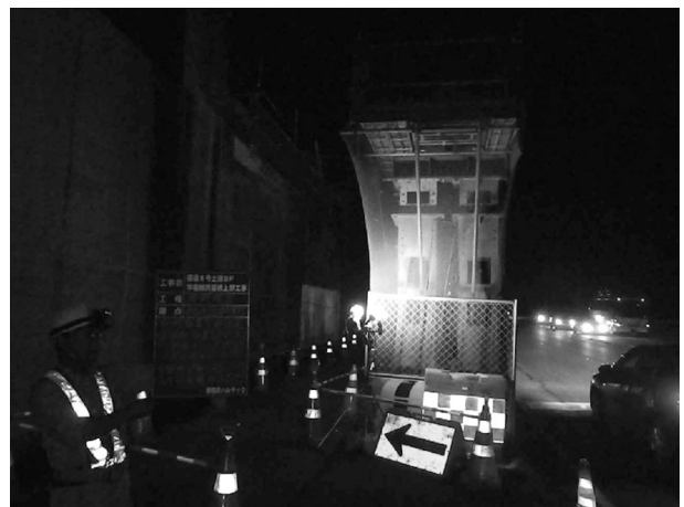
図-5 ベント設備のライトアップ
