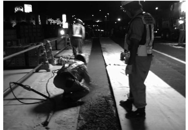
図-5 超速硬コンクリートの打設
