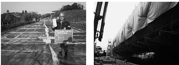
図-3 床版養生状況
