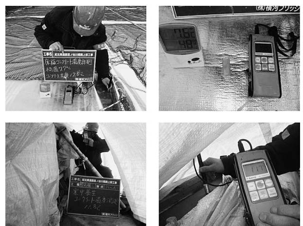
図-6 コンクリート温度計測状況
