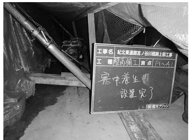
図-5 壁高欄養生状況
