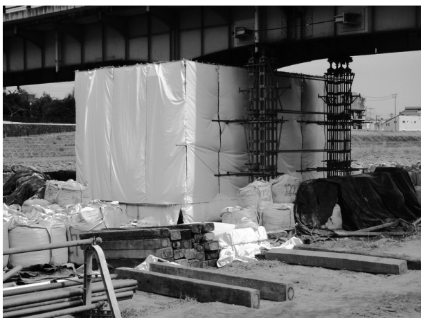
図-2 養生シート設置
