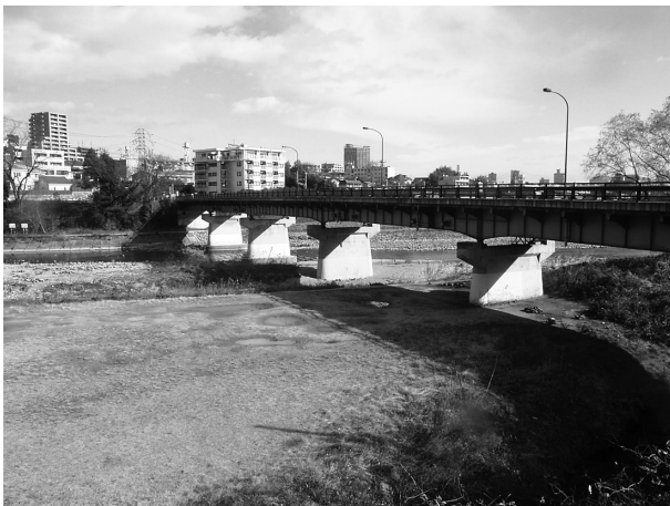
図-1 施工前状況
