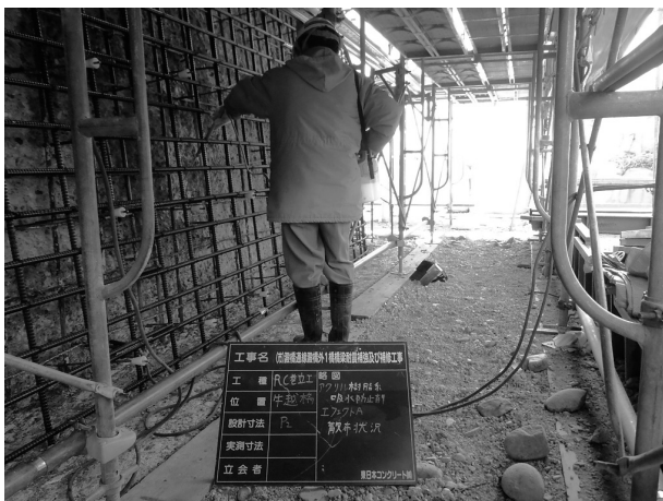
図-4 エフェクトA塗布状況
