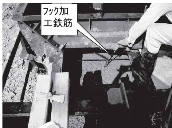
図-5 加工鉄筋取付時のコンクリート打設
