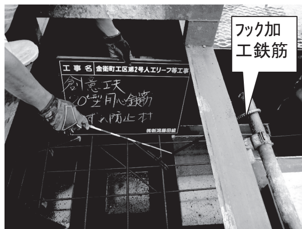
図-4 単管パイプ及び加工鉄筋取付状況
