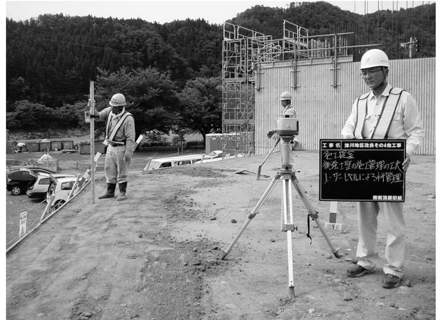
図-3 レーザレベルによる測量
