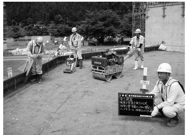
図-1 補強土壁背面盛土施工状況
