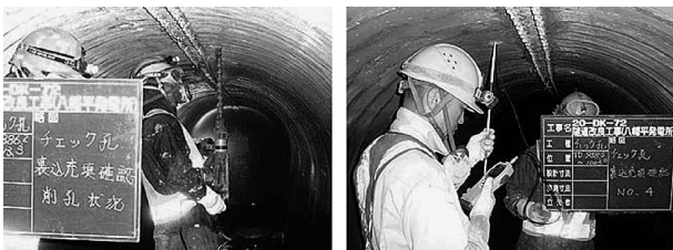
図-2 注入孔削孔状況 図-3 内視鏡による充填確認
