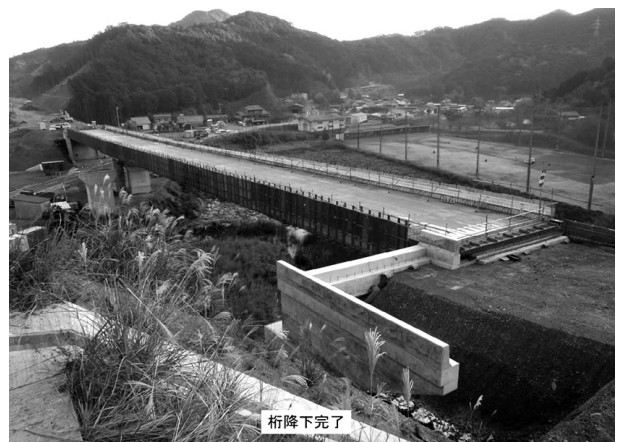
図-6 施工完了状況
