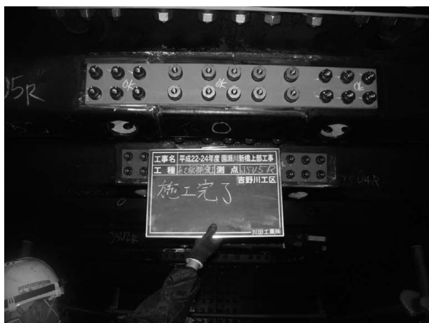
図-4 当て板補強工（標準部）
