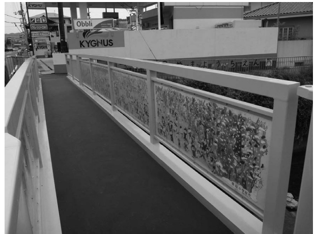
図-3 完成した側道橋
