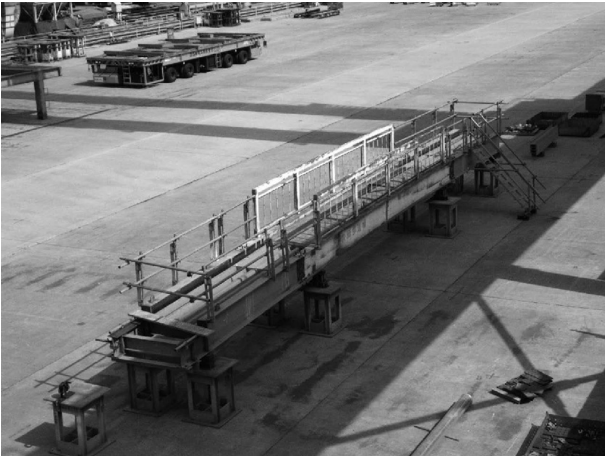
図-2 仮組立状況
