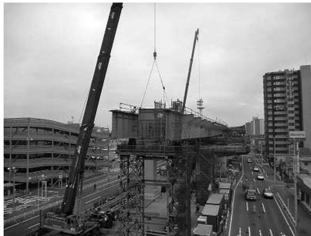
図-1 鋼桁架設状況
