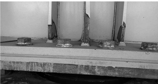
図-3 支点上補剛材の変形状況
