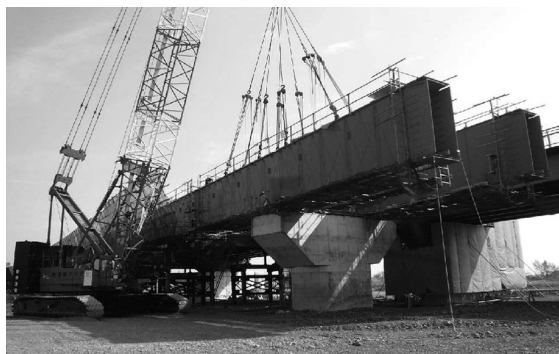
図-5 主桁架設状況
