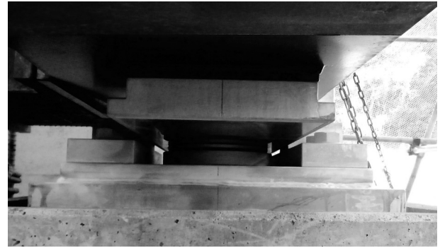
図-6 ベースプレートを追加した鉛直支承 (完成時)
