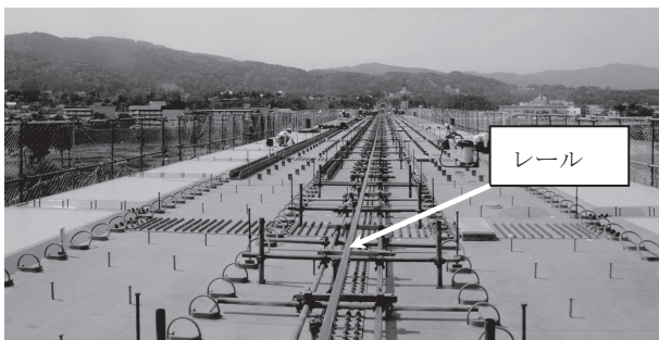
図-3 レール設置状況
