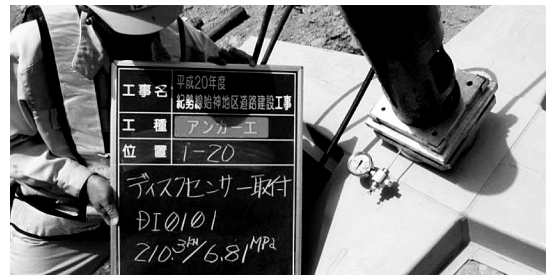
図-5 荷重計の設置
