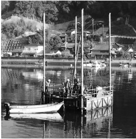
図-3 スパット台船によるチェックボーリング
