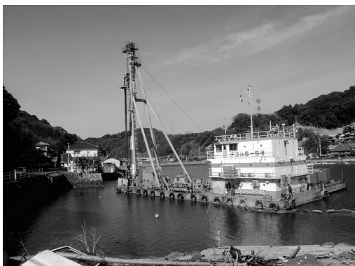
図-1 深層混合処理船による海上地盤改良
