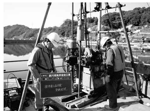
図-5 改良体確認状況
