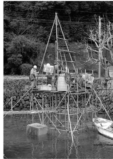
図-4 足場設置によるチェックボーリング
